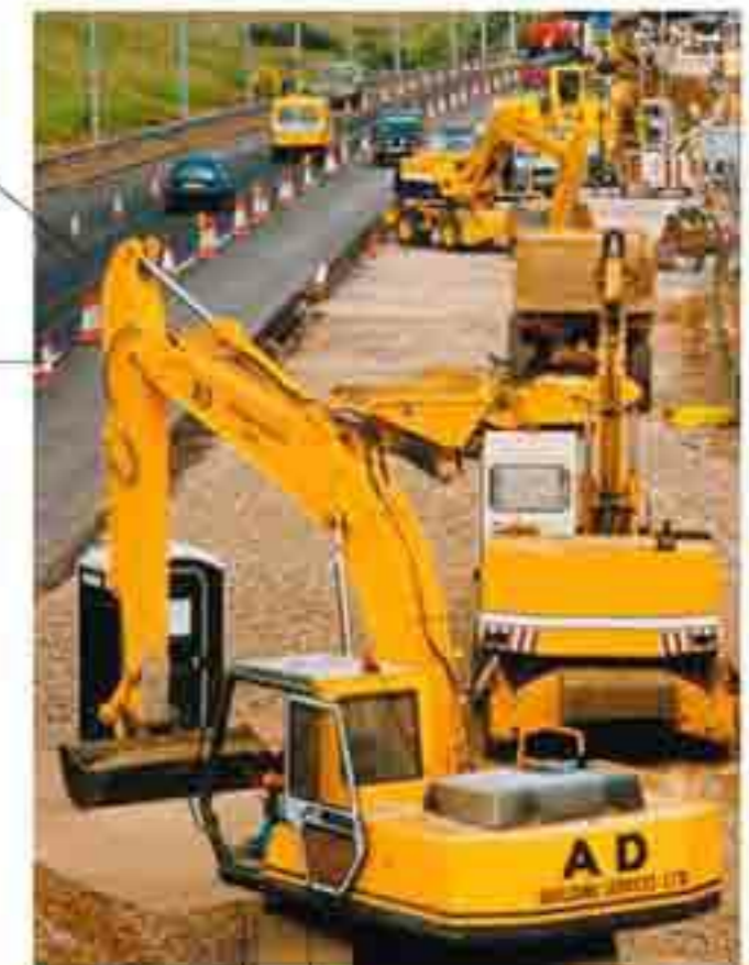
إعادة رصف iAaadat rasf resurfacing
